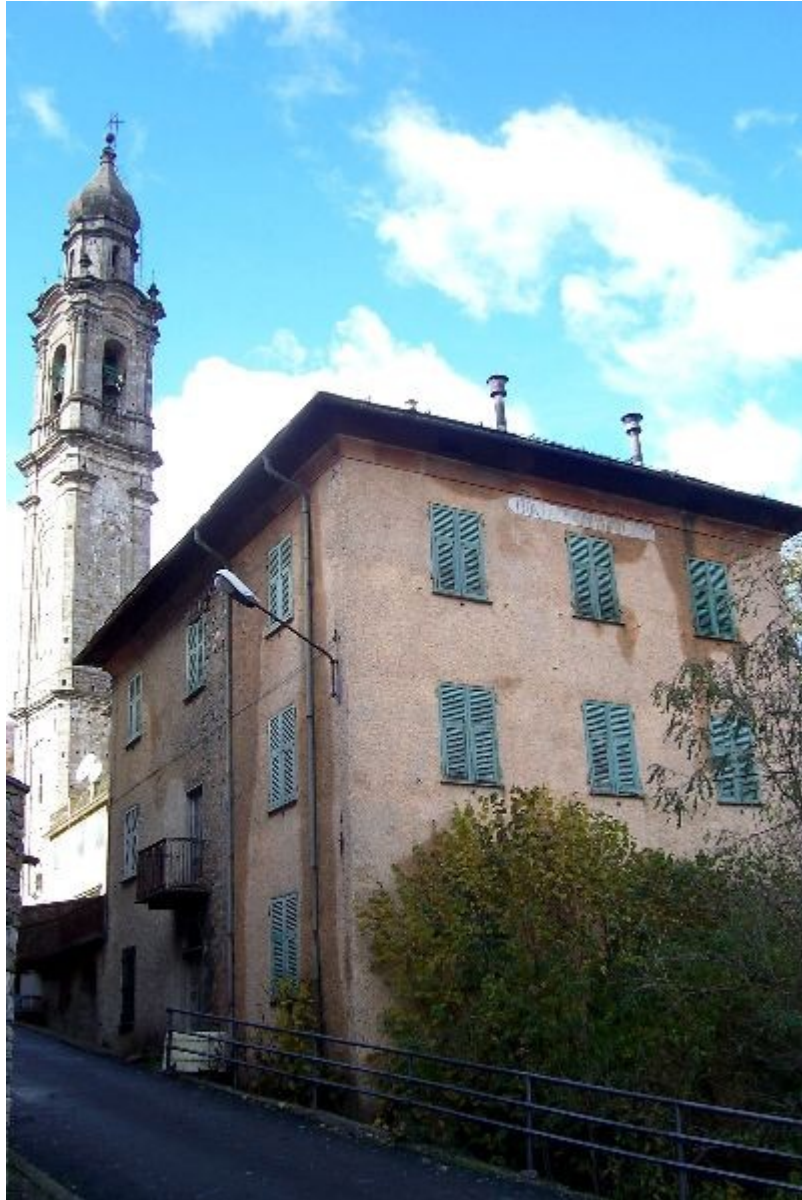
Casa Emporio Garbarino a Rezzoaglio –foto Sandro Sbarbaro
